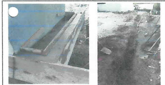
FOTO 5: FUNDICIÓN DE LAVAMANO E INSTALACIONES HIDRAULICAS Y DRENAJE PARA ELEMENTOS DE COCINA
