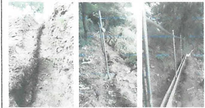
FOTO 1: ZANJEO, COLOCACIÓN DE TUBOS, FUNDICIÓN DE CIMIENTO CORRIDO Y COLOCACIÓN DE BLOCK SOLERA
