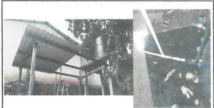
FOTO 4: CAMBIO DE LÁMINA Y REPARACIONES EN LINEA DE ABASTECIMIENTO DE AGUA Y SISTEMA INTERNO DE TINACO DEJÁNDOLO EN FUNCIONAMIENTO
