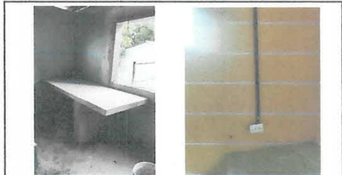
FOTO 6: FUNDICIÓN DE MUEBLE DE CONCRETO EN COCINA E INSTALACIÓN DE SISTEMA ELÉCTRICO EN AULAS Y COCINA
